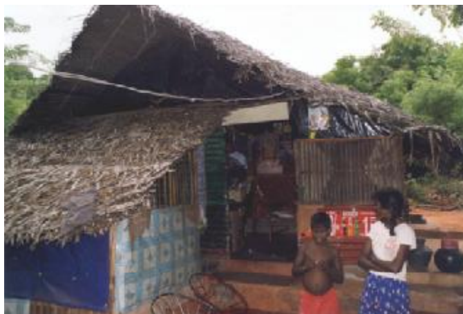
Eén van de huizen die gerenoveerd moeten worden
