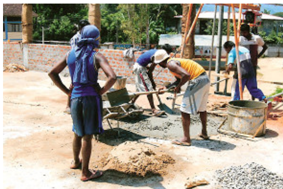
De bouw van het weeshuis in Badulla is in volle gang
